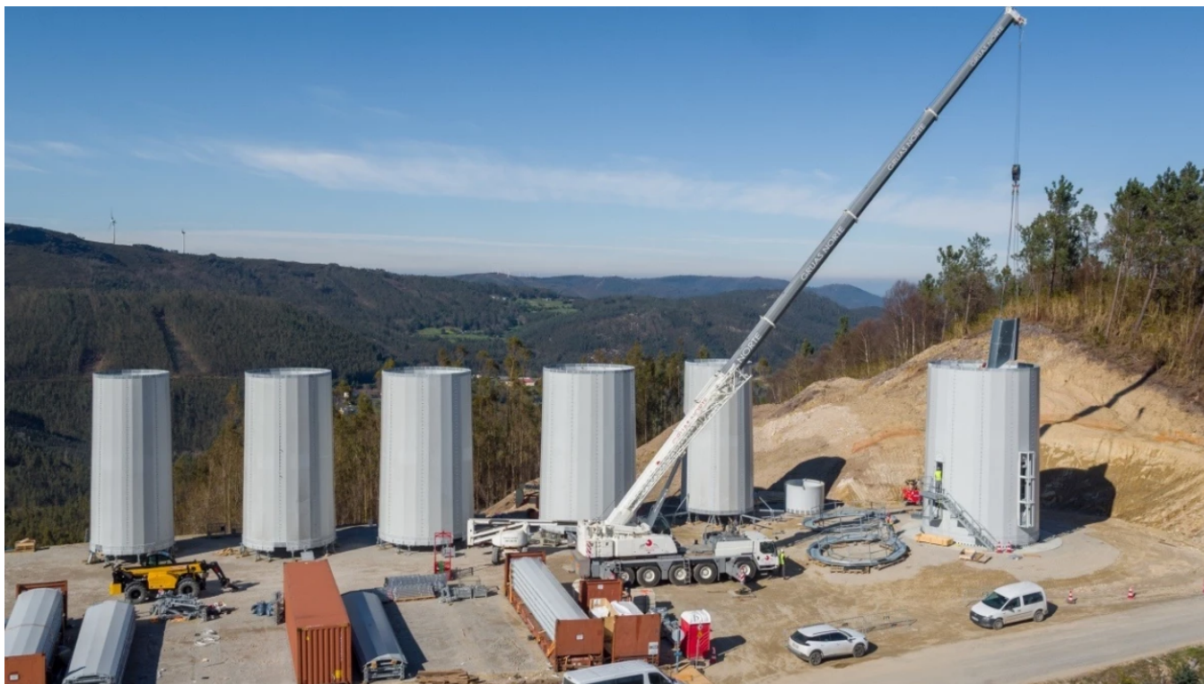
Construcción de un parque eólico de Greenalia
